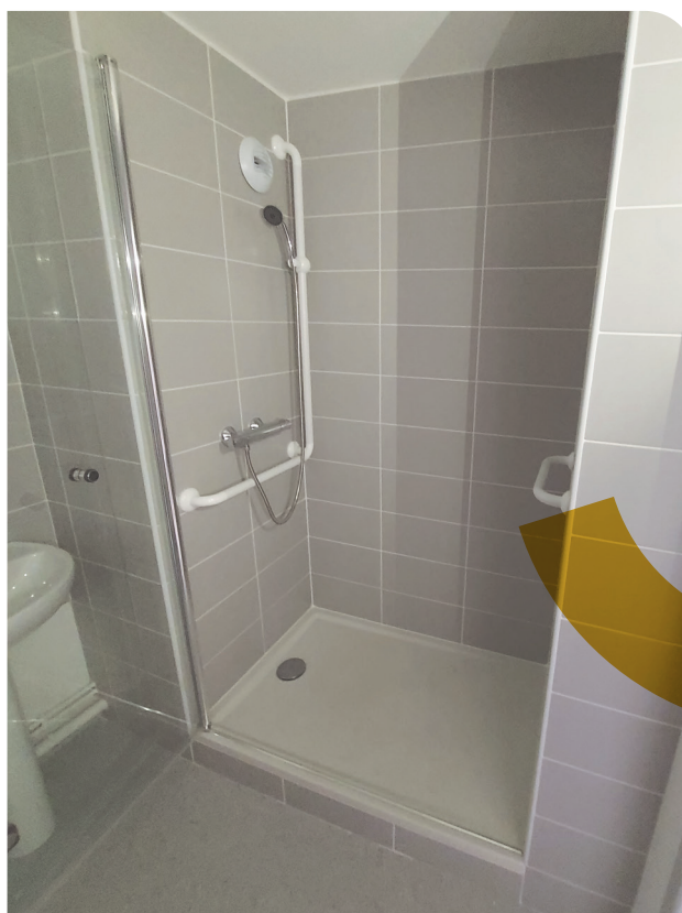
Installation d'équipements spécifiques facilitant le maintien à domicile : barres d'appuis, douches adaptées.
