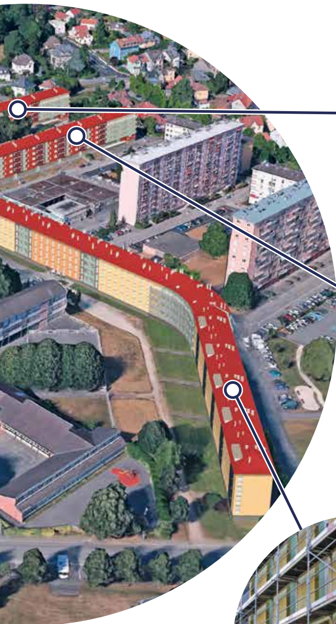
Rue de Verdun (57 logements) ►
