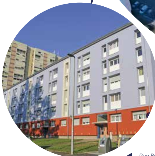
◀ Rue Braille (50 logements)
