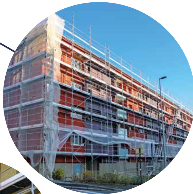
▲ Rue Mansart (57 logements)
