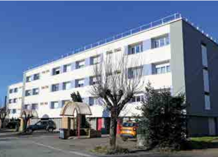
Giromagny, rue de la Gare
