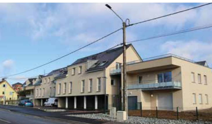
3 16-16A-16B rue du Général de Gaulle à Essert
