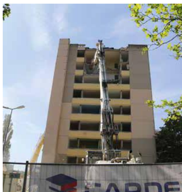
3 12 rue Renoir à Offemont
