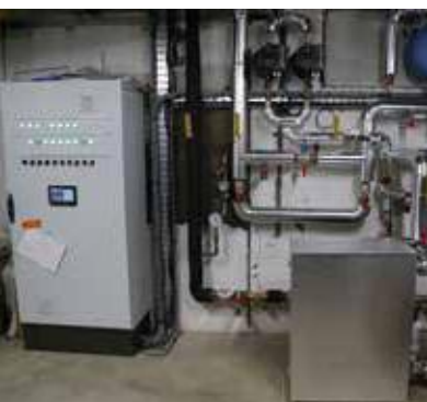
Rénovation de la chaufferie 12 rue de Giromagny à Belfort
