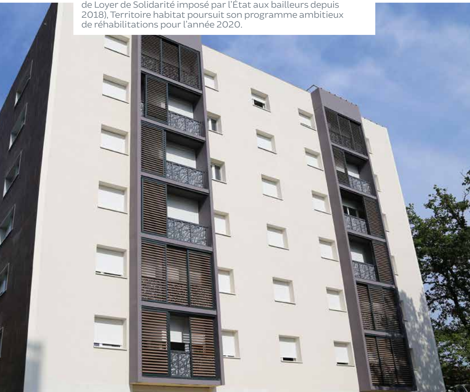
1 2-4-8 rue Renoir à Belfort
