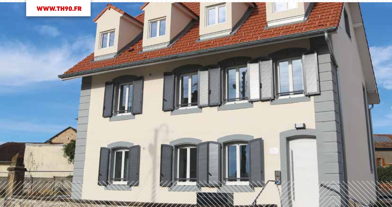
L'ancienne ferme « Courtot » située à Châtenois-les-Forges réhabilitée
