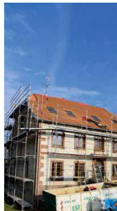
2 4 rue du Presbytère, à Phaffans (3 logements)
