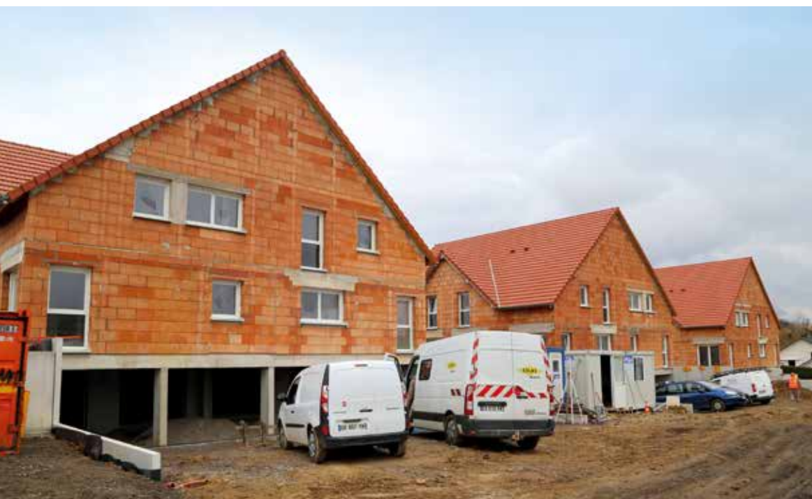
1 Les Carrés de la Jonxion, à Moval (12 logements)
