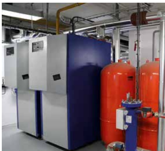
La chaufferie rue Chappuis a été entièrement renouvelée.
