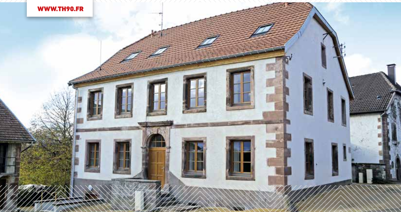
L'ancien presbytère situé au cœur du village de Phaffans réhabilité
