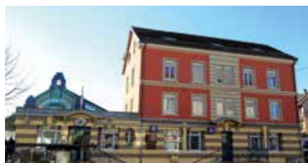
Façade rénoverée au 117 avenue Jean Jaurès à Belfort, en partenariat avec la Mairie de Belfort
