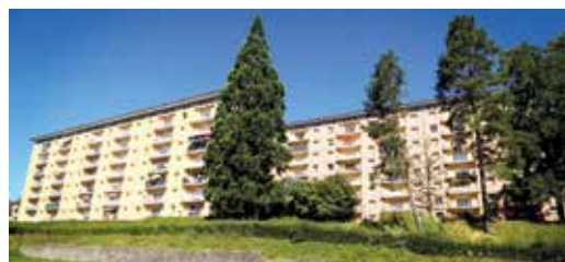
1 Rue Chappuis, Belfort
