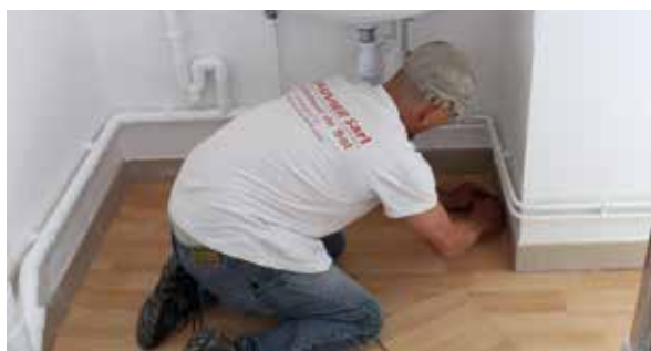
La remise en état des logements : une priorité de Territoire habitat
