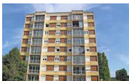
12 rue Renoir, une démolition prochaine
