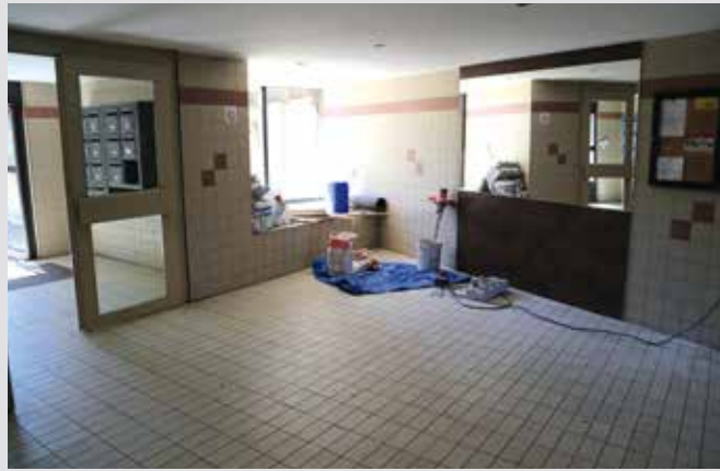
Le grand hall du 36 Faubourg de Lyon en chantier
