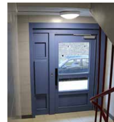
Des entrées et des montées d'escaliers rénovées et sécurisées
