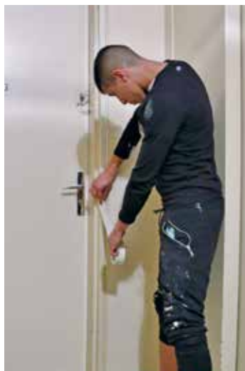
Un jeune du Quartier Bougenel prépare le chantier
