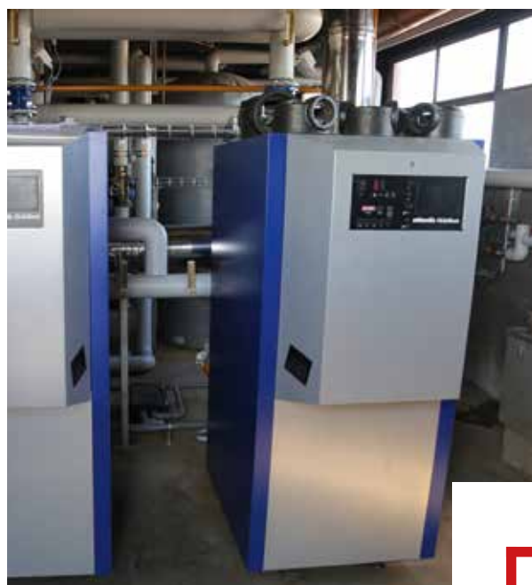
La rénovation des chaufferies contribue à la réduction des charges locatives
