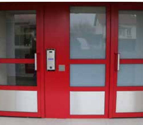
Porte d'entrée et communs rénovés rue des Vosges à Danjoutin
