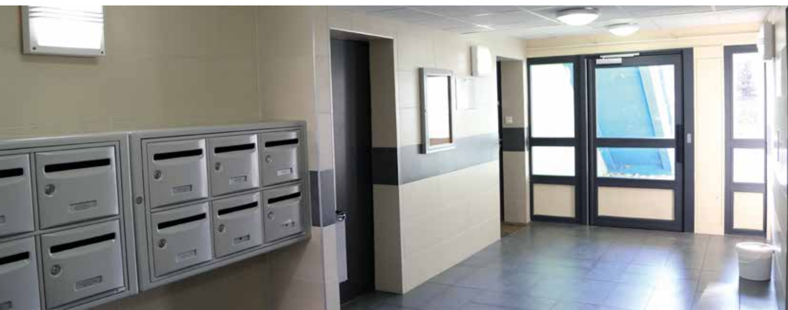
Le hall rénové de la rue de la Fraternité à Belfort
