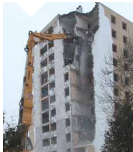
Démolition 2 rue des Vosges à Delle
